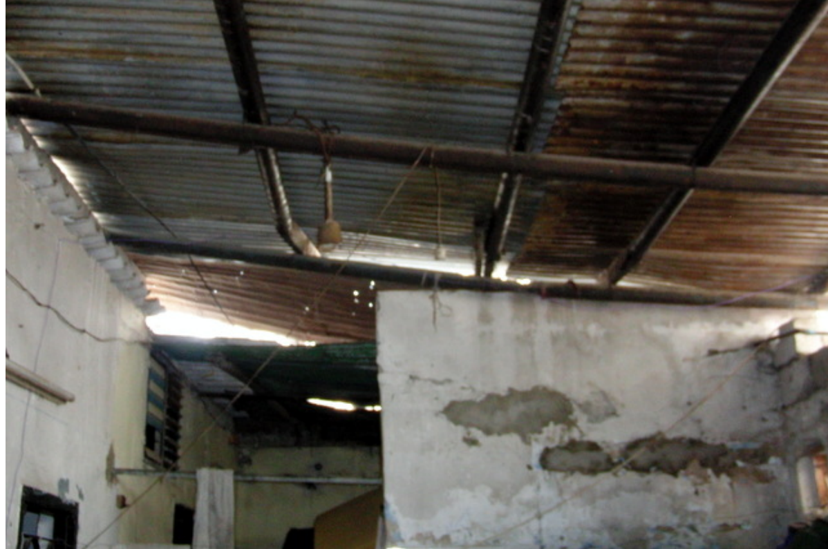
Blick aus dem Wohnzimmer: Dach und Hauswand
